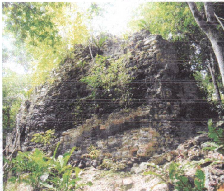
Figura 18. Estructura expuesta, Sitio Tzikin Tzakan.
