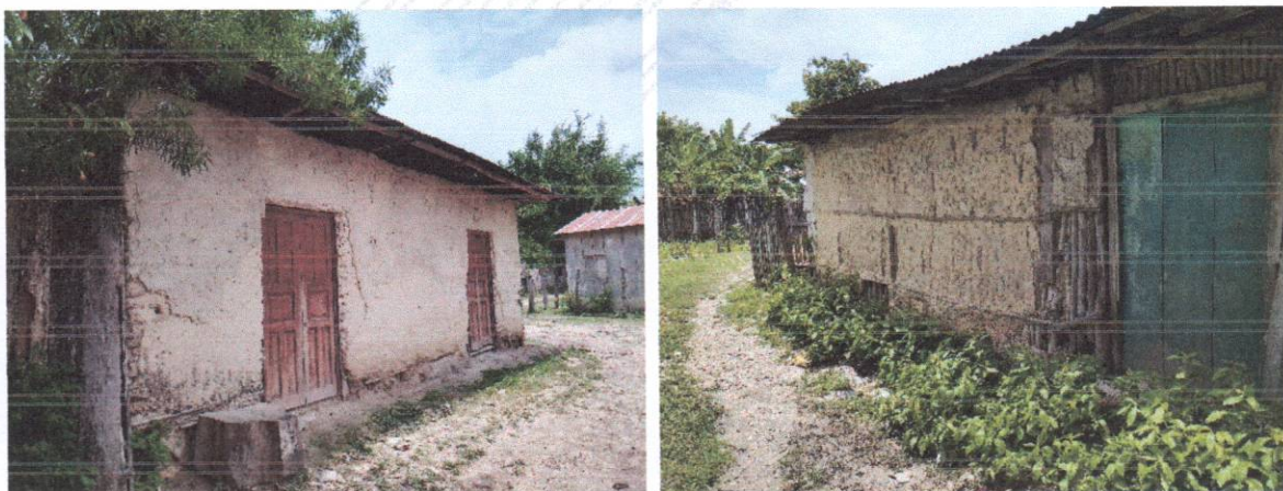
Figura 37. Ejemplos de otras dos casas con este tipo de construcción de bajareque.
