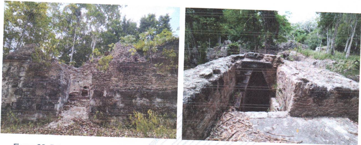
Figura 29. Estructuras sin protección y con saqueos recientes. Izq. Saqueo, Der. Estructura principal.
