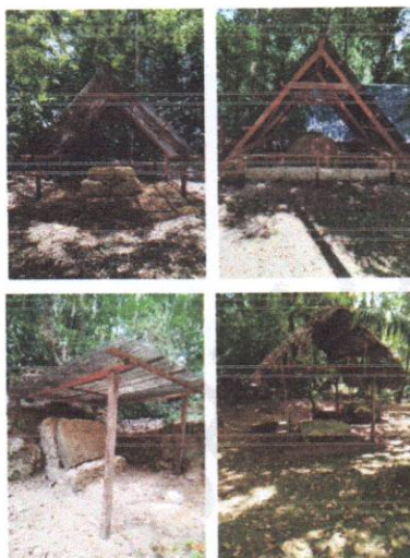
Figura 34. Sitio Waka-Perú. Arriba e izquierda inferior estelas y altares intervenidos y con techo adecuado.
