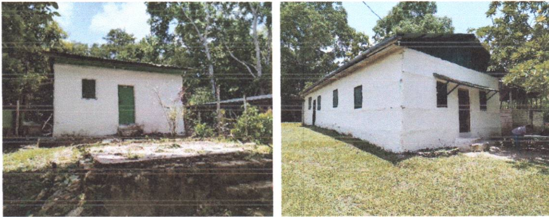
Figura 60. Der. Casa Habitación de Uaxactún; izq. Salón Comunal de Uaxactún.
